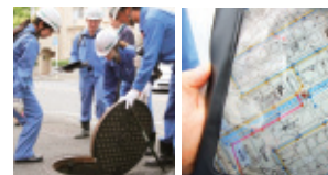
横浜市の下水道管実地調査訓練の様子
